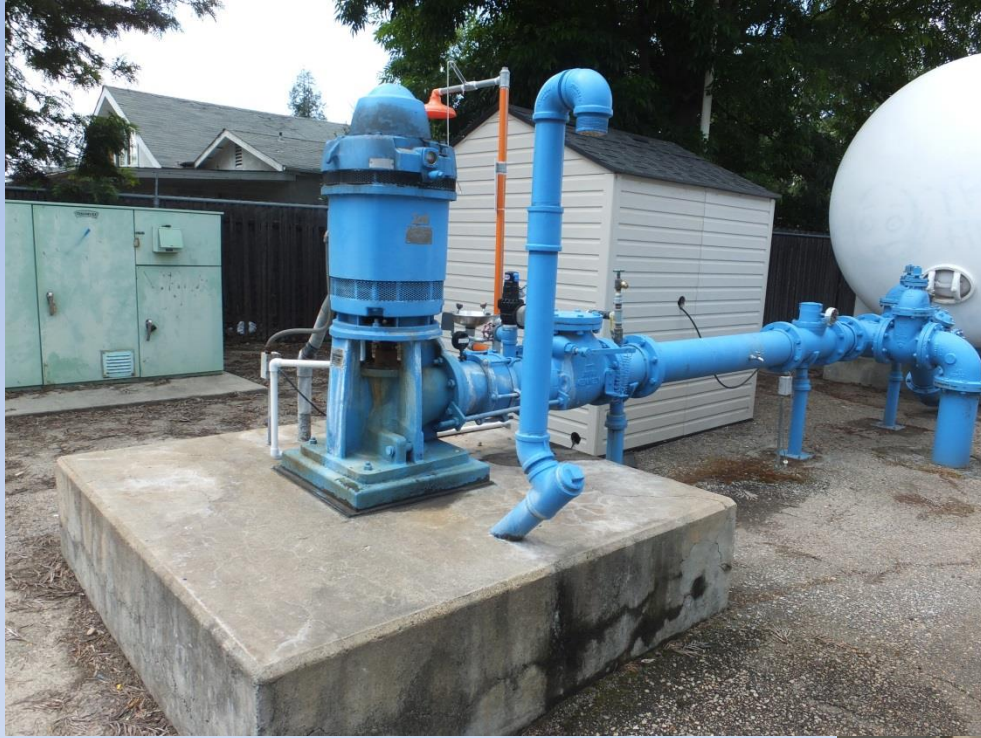
Pozo sin tratamiento
