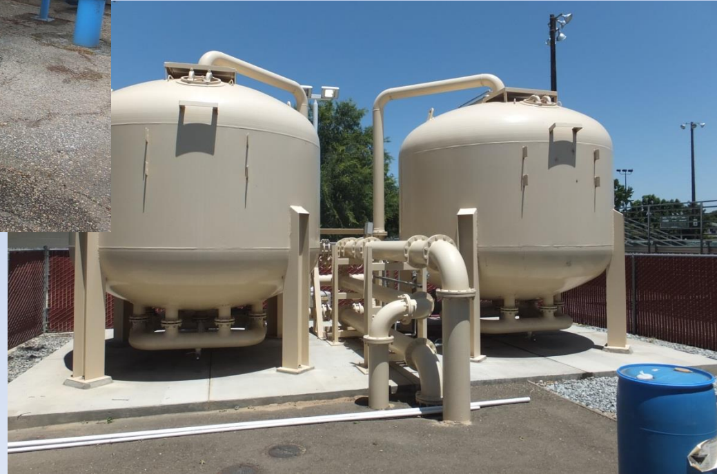
Tratamiento con carbón granulado activado (GAC)
