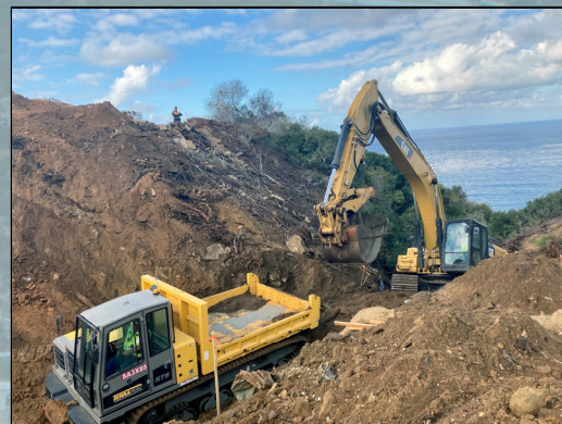
IR 7 TCRA excavation
