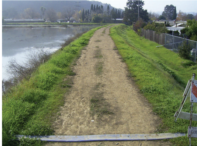
Gallinas Creek levee
